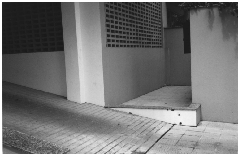
Figura 1 - Vão próximo à rampa de acesso à garagem
