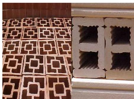
Figura 4 – Bloco vazado aparente e plaquetas de revestimento (Cerâmica F)
