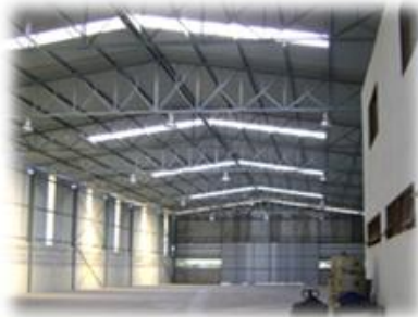
Figura 12 - Exemplo de galpão com iluminação natural
