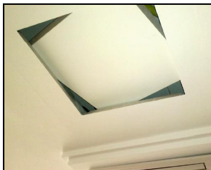
Figura 5 – Alçapão instalado
