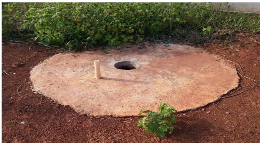
Figura 4 – Cavidade subterrânea para armazenamento temporário de dejetos
