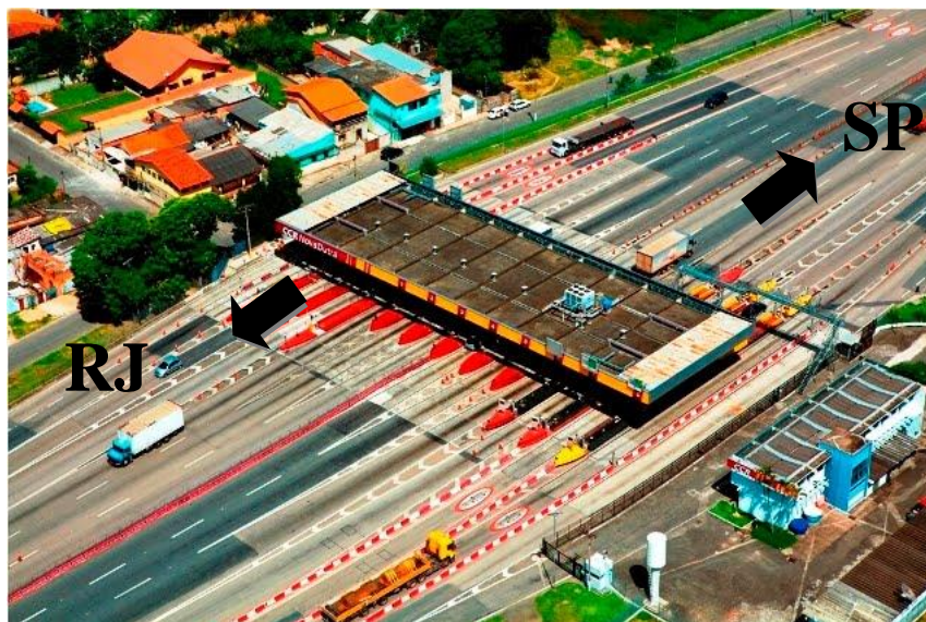
Figura 1 - Vista aérea da Praça de Pedágio Itatiaia.
