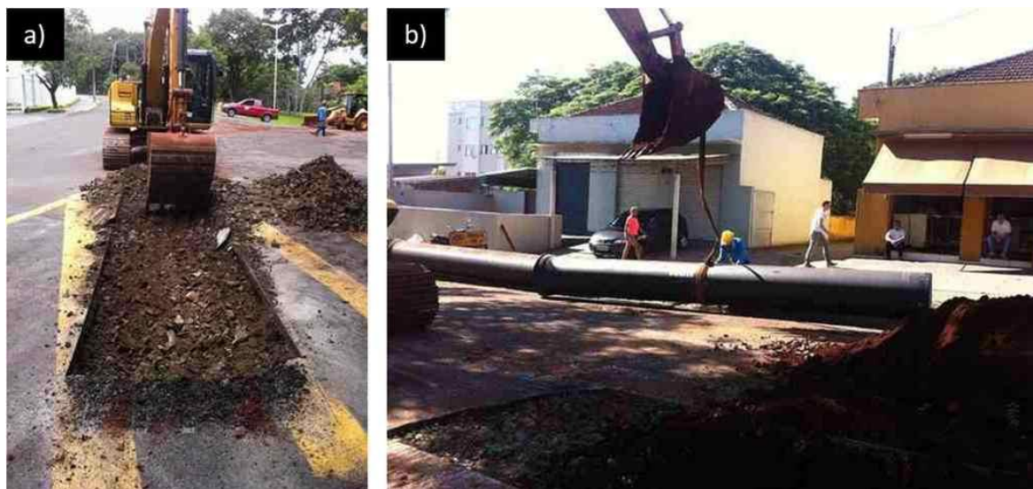
a) Abertura de vala para assentamento de tubo; b) Inspeção, preparo e içamento da tubulação.
