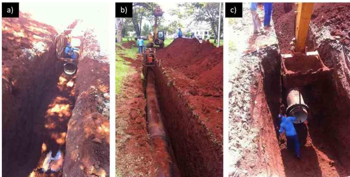
a) e b) Funcionários dentro da blindagem de contenção; c) Funcionários sem o uso da blindagem de contenção.
