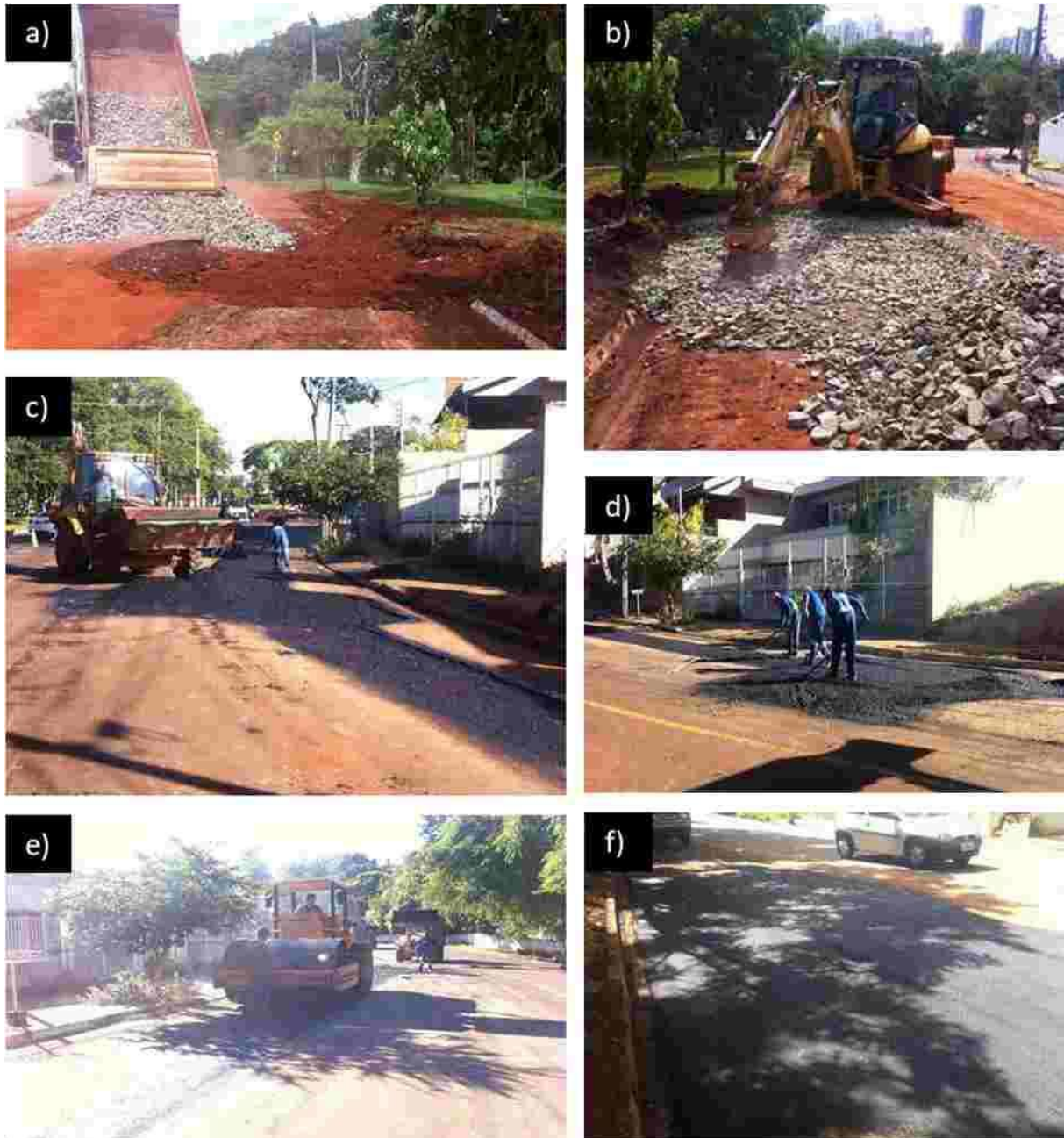
Figura 10—Fechamento de vala e pavimentação
