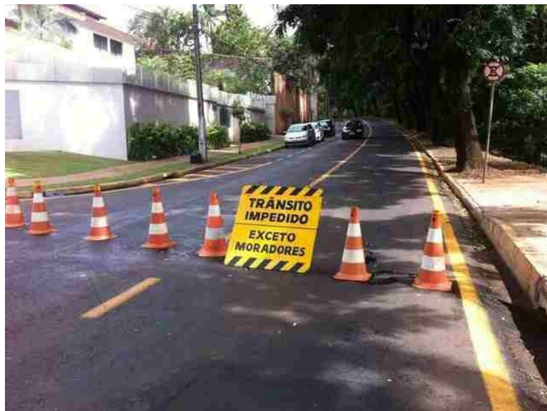
Figura 6–Sinalização e isolamento das vias do local da obra
