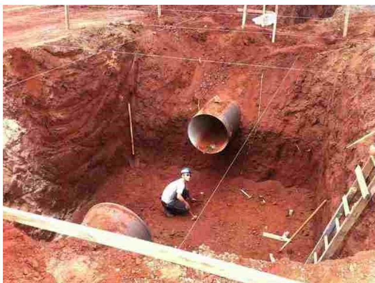
Figura 8–Locação e alinhamento da tubulação
