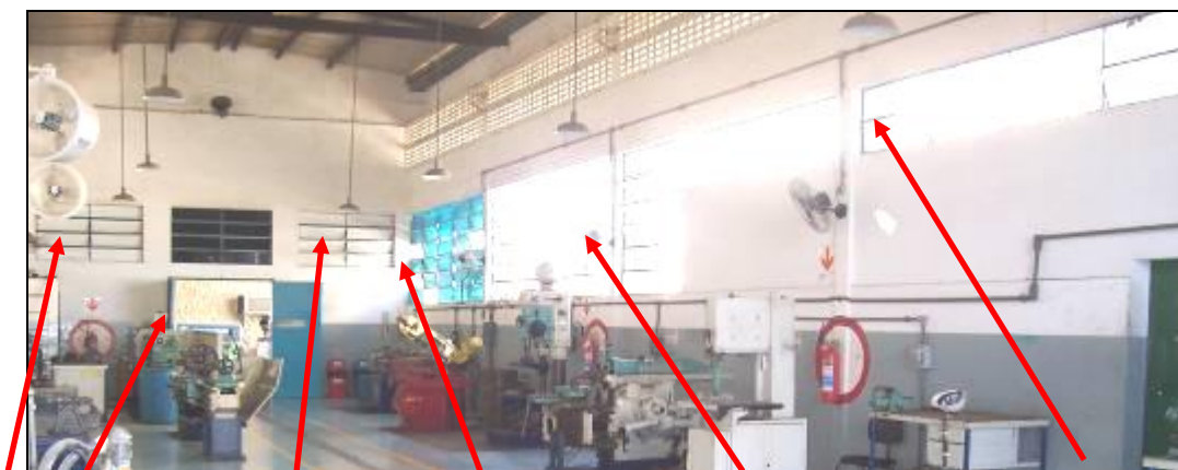
Figura 7 – Pontos de ventilação da oficina de manutenção mecânica de Furnas Fonte : Própria
