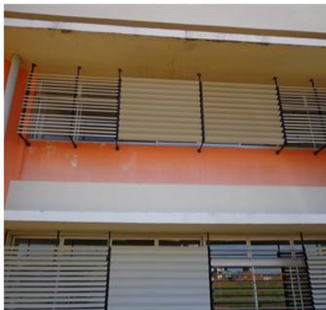
Figura 2 - Janelas do pavilhão de aulas
