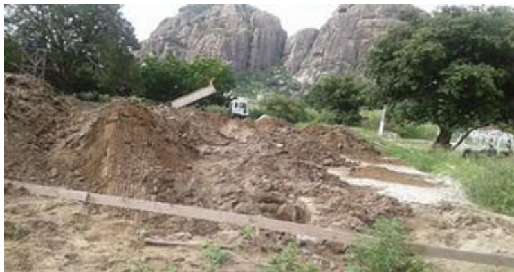
Figura 3 - Construção da quadra na etapa de Terraplenagem e Fundações
