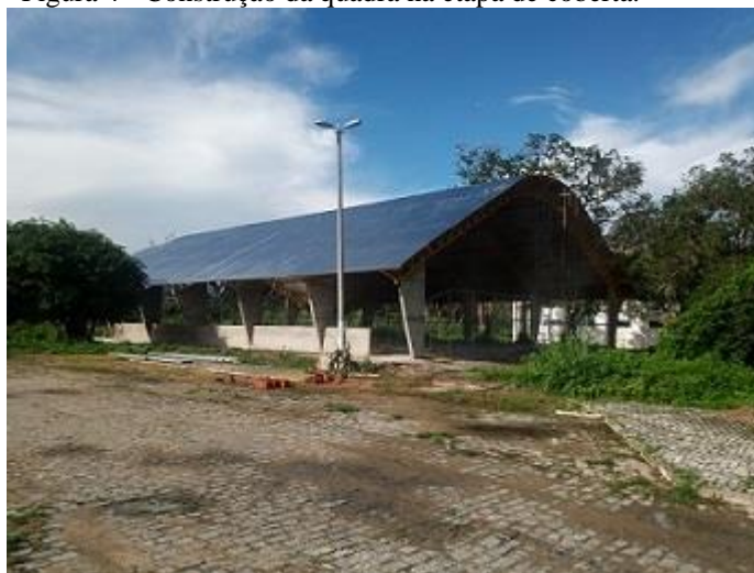
Figura 4 - Construção da quadra na etapa de coberta.
