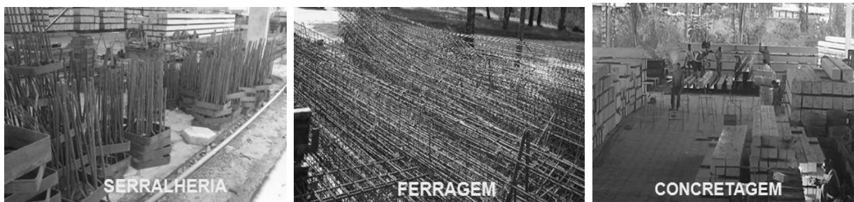
Figura 2 - Estoque de produtos semi-acabados e acabados entre os processos de produção
